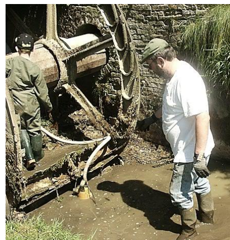
Le dévasement de la roue, il a fallu plusieurs journées « retrousse-manches » pour en arriver à bout
