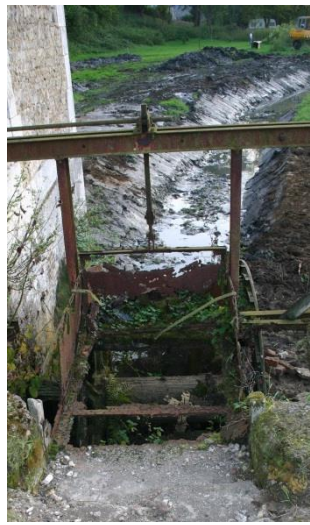
Creusage du chenal en aval avec vue sur l'ensemble vanne avant réfection
