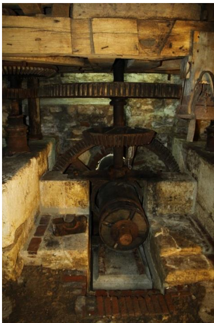
La réfection des assises en briques et pierres de la fosse
