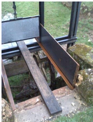
Réfection du pignon de la crémaillère, de la vanne de commande et de son bac déversoir
