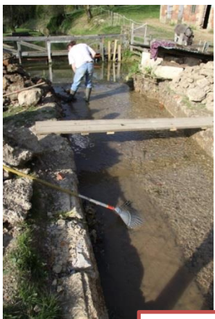
Après plusieurs semaines Les derniers efforts de terrassement du chenal en amont afin de permettre à l'eau d'arriver sur la roue... ça m'a valu une tendinite.
