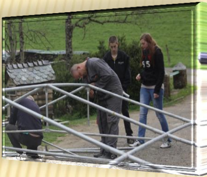
Philippe et Julien au montage des tubulures
